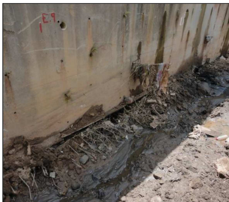
Figura 6. Armadura exposta no pé da cortina
