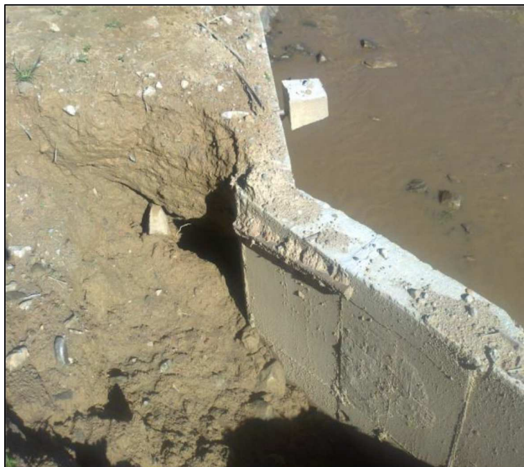
Figura 5: Remoção de material no topo a montante da cortina.
