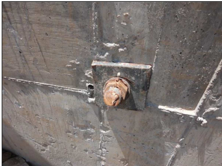
Figura 4. Danificação em cabeça de tirante.
